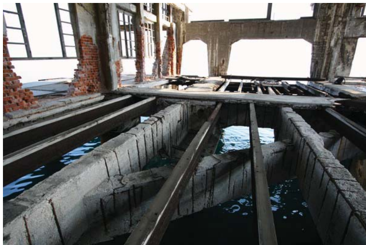
Slika 4. Detalj radne platforme odozgo
