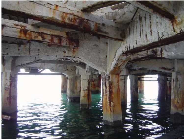
Slika 3. Detalj pilota i radne platforme odozdo
