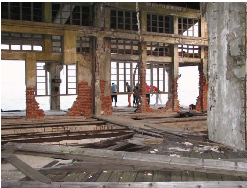
Slika 5. Detalj bočnih zidova lansirne rampe
