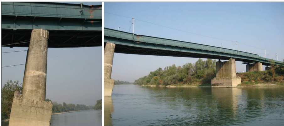
Slika 4.1. Most „Jakuševac“ nakon gubitka stabilnosti
