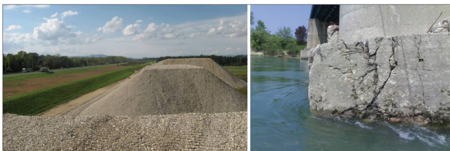
Slika 4.2. Primjeri uzroka i posljedica erozije prirodnih vodotoka
