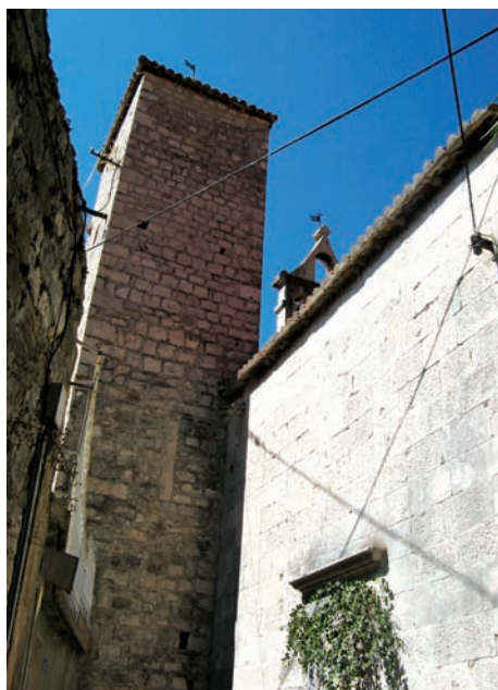
Začelje tornja javnog sata sa zazidanim vratima
