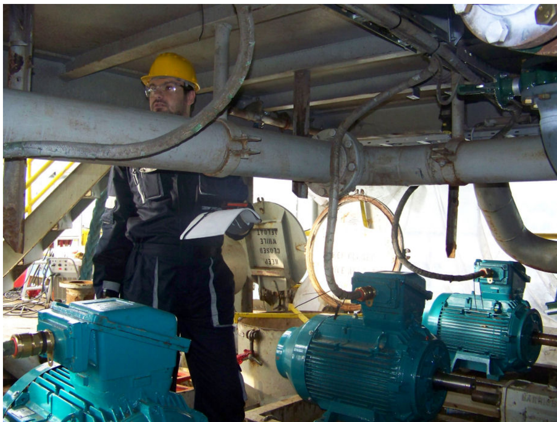
Slika 3.2 - Mjerenje cjevovoda na platformi prije izrade 3D modela i dokumentacije
