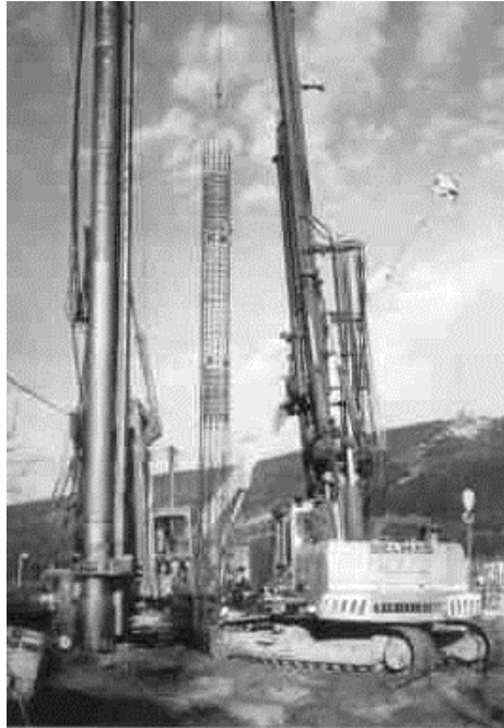
Slika 5.74 Zaštitna cijev, s krunom na dnu, lijevo i koš spreman za ugradnju, u sredini
