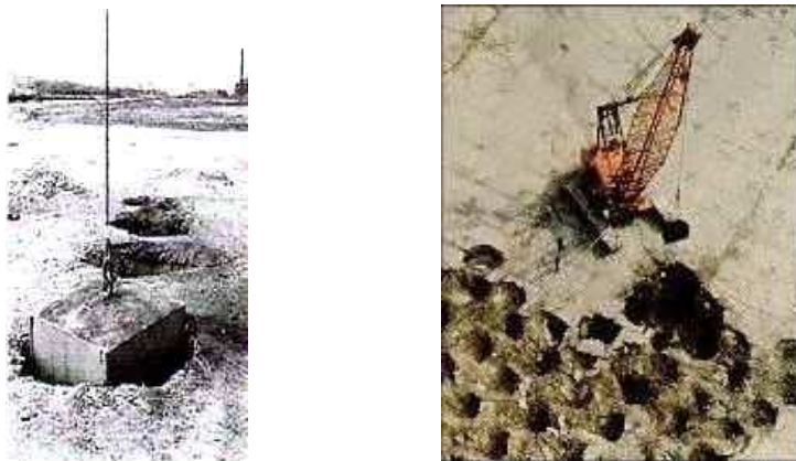
Slika 9.21 Učinak pada utega pri dinamičkoj stabilizaciji (WEB 6)
