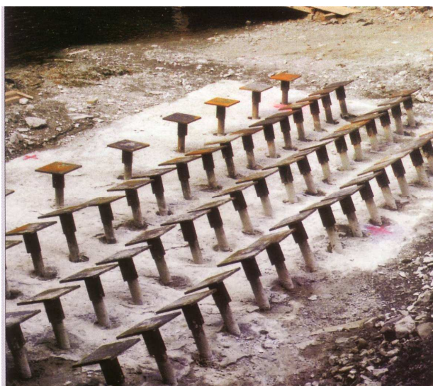
Slika 8.14 Glave unakrsnih pilota izvedenih od čeličnih cijevi
