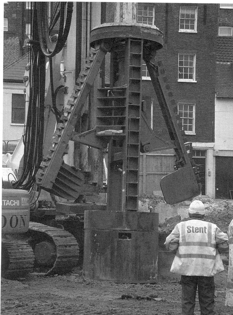
Slika 7.2b Uređaj za proširenje stope u otvorenom položaju (Fleming i dr. 2009.)
