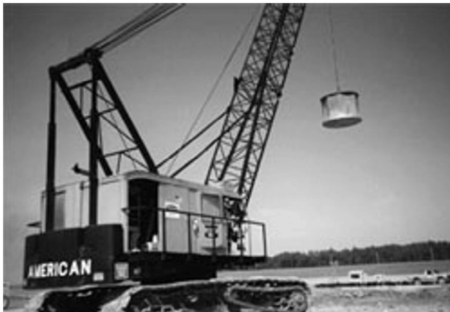
Slika 9.20 Oprema za dinamičko zbijanje tla
