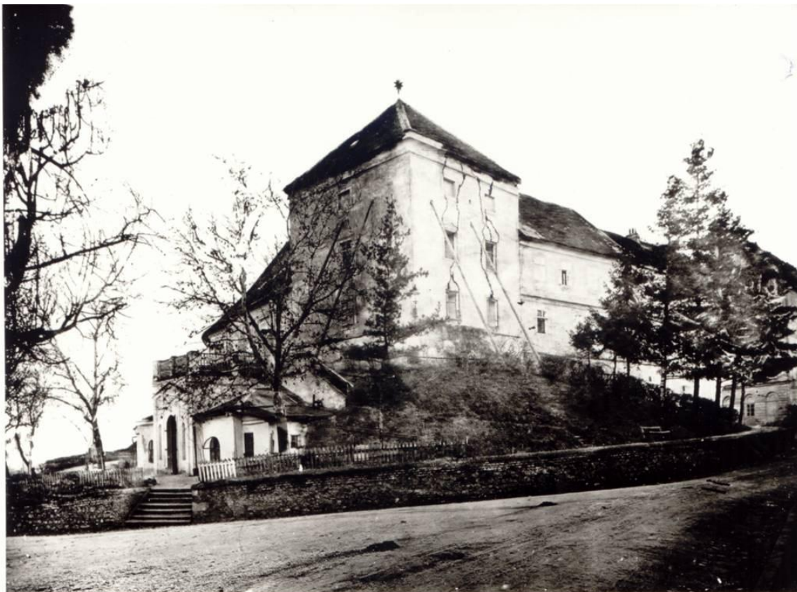
Slika 9. Popov toranj nakon potresa
