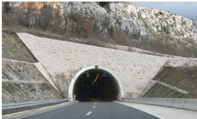
Slika 12. Čelo predusjeka obloženo kamenom oblogom
