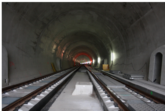
Slika 20. Kolosijek na čvrstoj podlozi u tunelu
