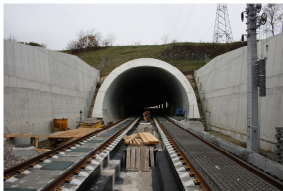
Slika 21. Prijelazna zona kolosiječne konstrukcije
