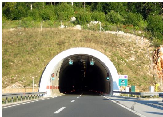
Slika 11. Zasuta i zatravljena portalna građevina
