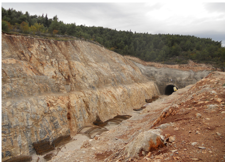
Slika 15. Izlazni usjek lijevog kolnika autoceste
