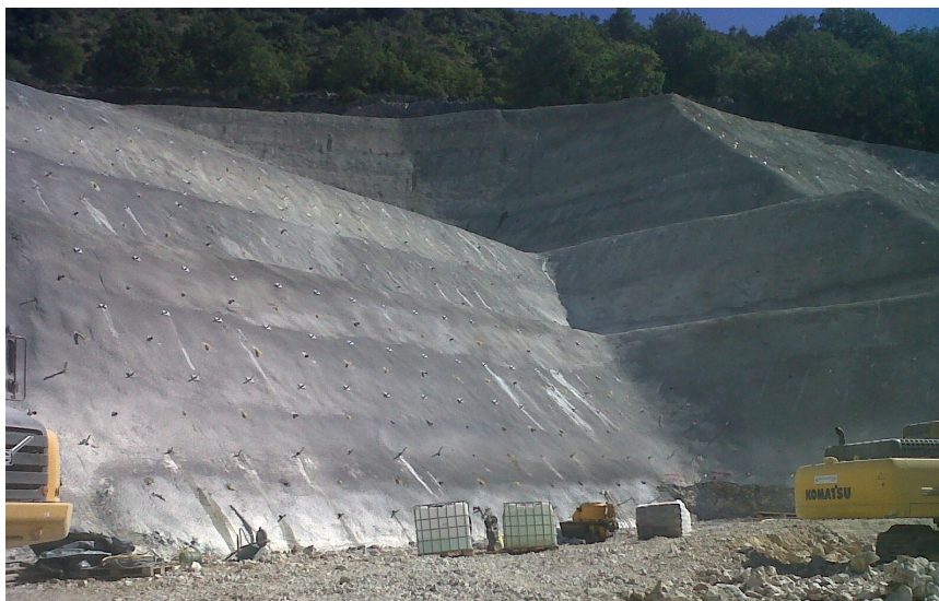
Slika 13. Pogled na ulazni predusjek u fazi izvođenja (cca. 50% dovršenosti)
