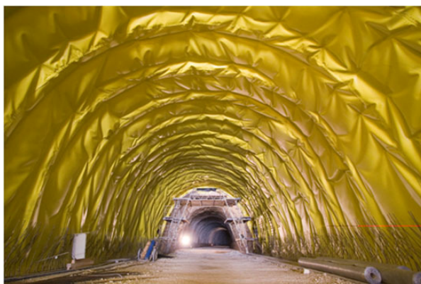
Slika 4. Hidroizolacija tunela
