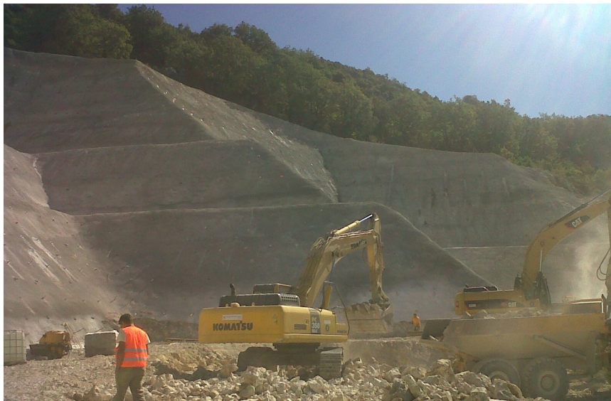
Slika 12. Pogled na ulazni predusjek u fazi izvođenja (cca. 50% dovršenosti)
