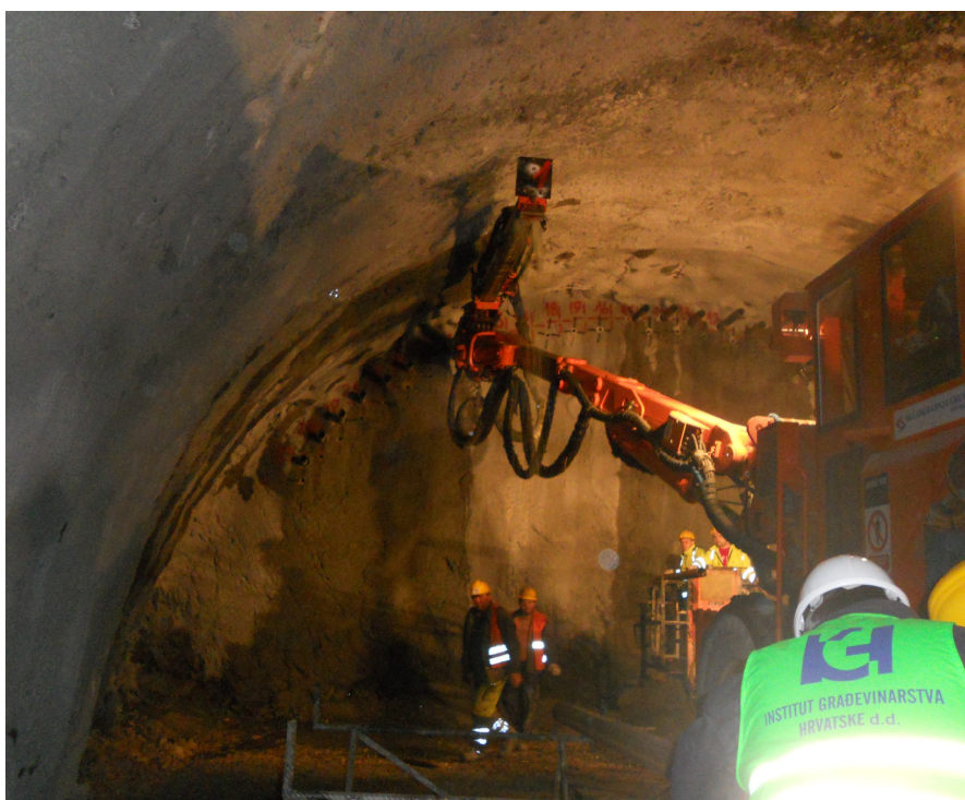
Slika 10. Iskop tunela Šubir metodom pipe-roof
