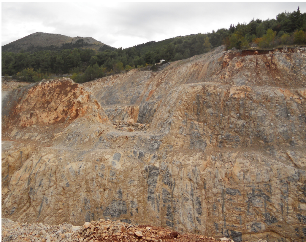
Slika 21. Vatrogasni prijelaz nakon dovršenog iskopa
