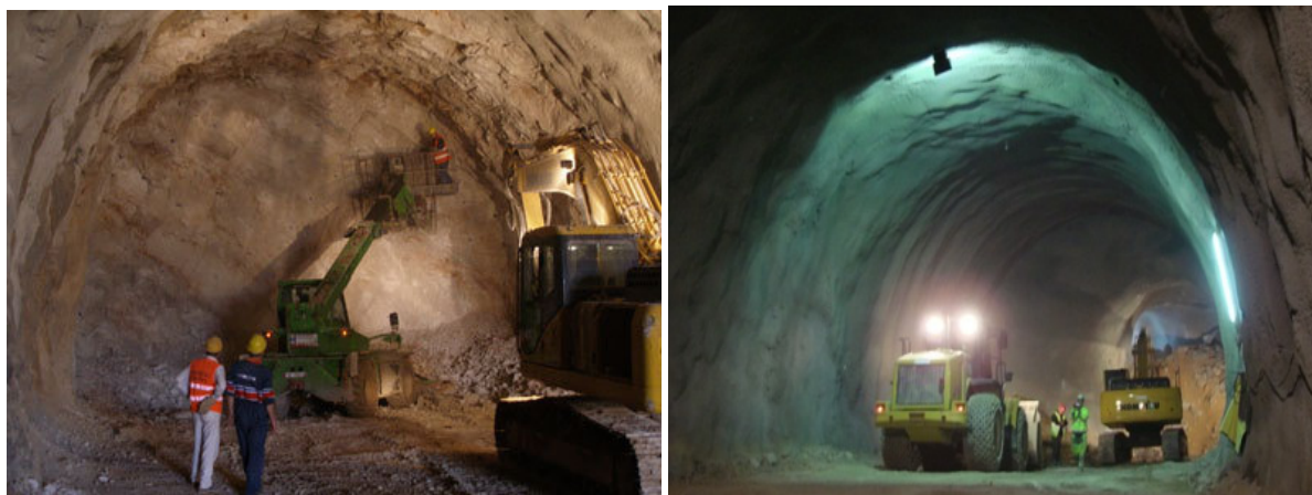
Slike 2. i 3. Radovi na iskopu tunela
