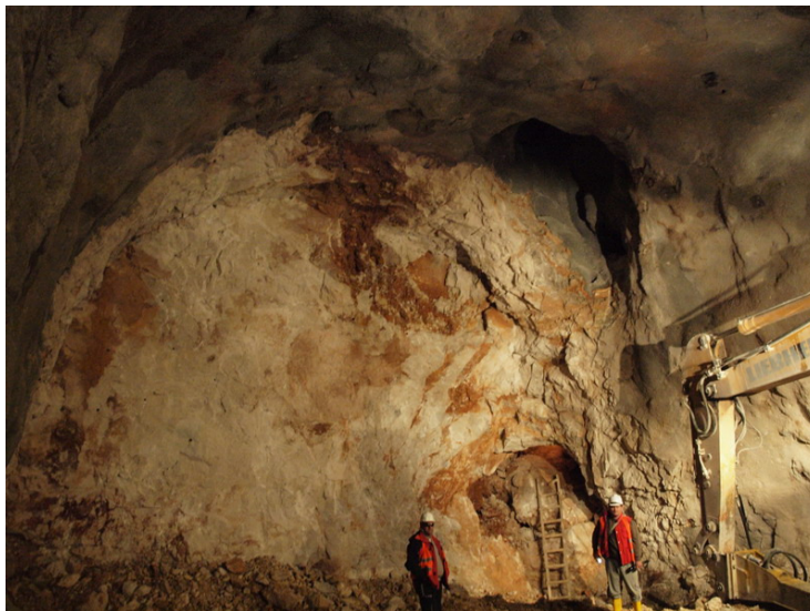
Slika 17. Ulaz u kavernu na čelu iskopa
