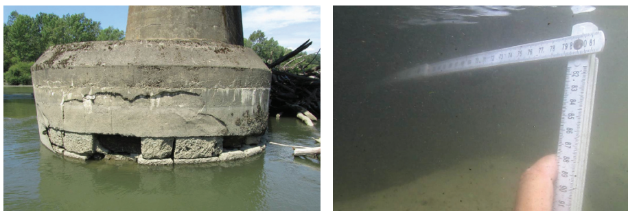
Slika 12. Nizvodna strana stupa: a) nedostaje nekoliko kamenih blokova; b) najdublja pukotina
