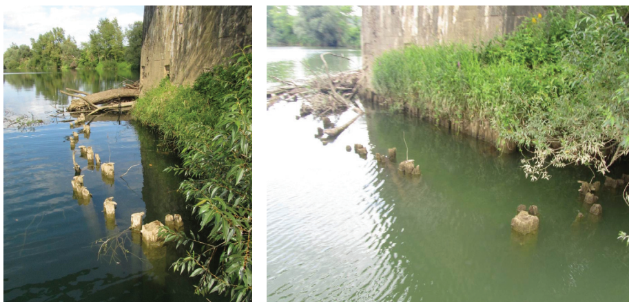
Slika 27. Drvene talpe snimljene na dan: a) 2. 9. 2010.; b) 2. 7. 2011.
