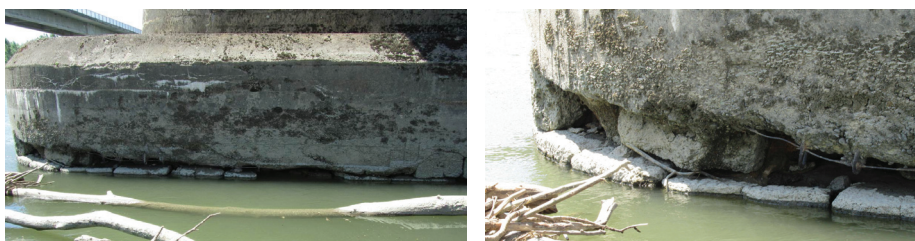
Slika 11. Lijeva strana stupa: a) oštećenje se pruža cijelom njegovom duljinom; b) detalj
