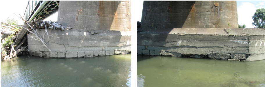
Slika 13. Desna strana stupa, također je vidljivo oštećenje i gomilanje plutajućeg nanosa
