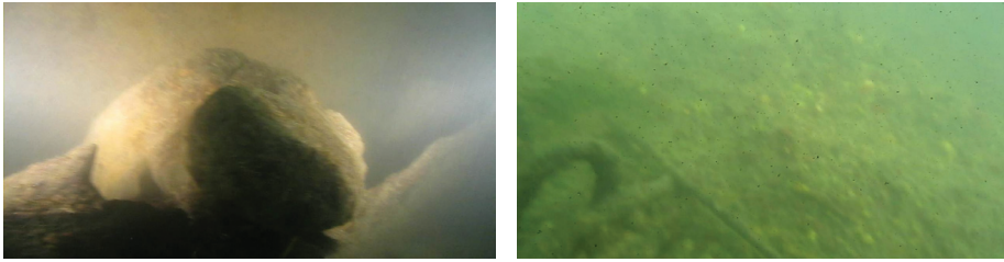
Slika 18. a) Foto 12 - ostatak čelične oplate kesona uz lijevu stranu stupa; b) Oštećenje A na rubu dubljev proširenja temeljne stope na desnoj strani stupa - vidljiva je armatura
