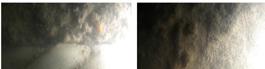
Slika 35. Čelična oplata kesona: a) Uz pješčano dno; b) Korodirana površina sa spojem od zakovica
