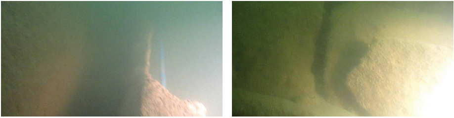
Slika 36. a) Odvojena čelična oplata kesona od temeljne stope na početku lijeve strane; b) Proširene reške između kamenih blokova ispune temeljne stope nakon odvajanja čelične oplata kesona
