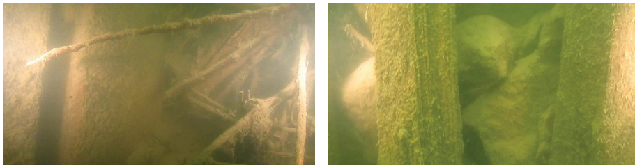
Slika 25. a) Foto 3 - nizvodna strana drvenog prstena s nanosom granja i sedimenta; b) Foto 4 - lijeva strana stupa, na mjestima gdje nedostaju drvene talpe vidljiva je kamena ispuna
