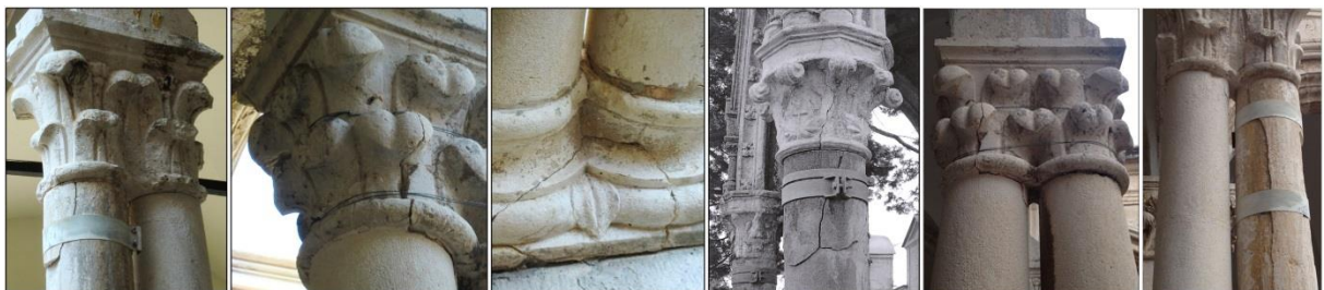
Slika 1. Pukotine na tradicijskim kamenim stupovima s ostacima prethodnih sanacija [1]
