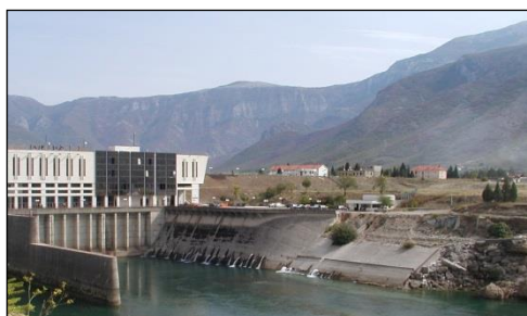
Slika 1. Hidroelektrana Mostar s lijevom zaobaljem
