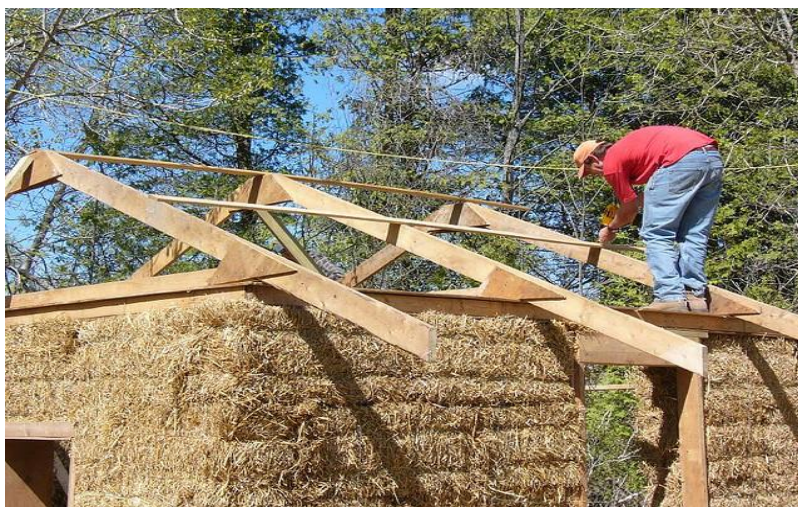
Slika 5. Gradnja kuće nebraskanskom metodom [8]
