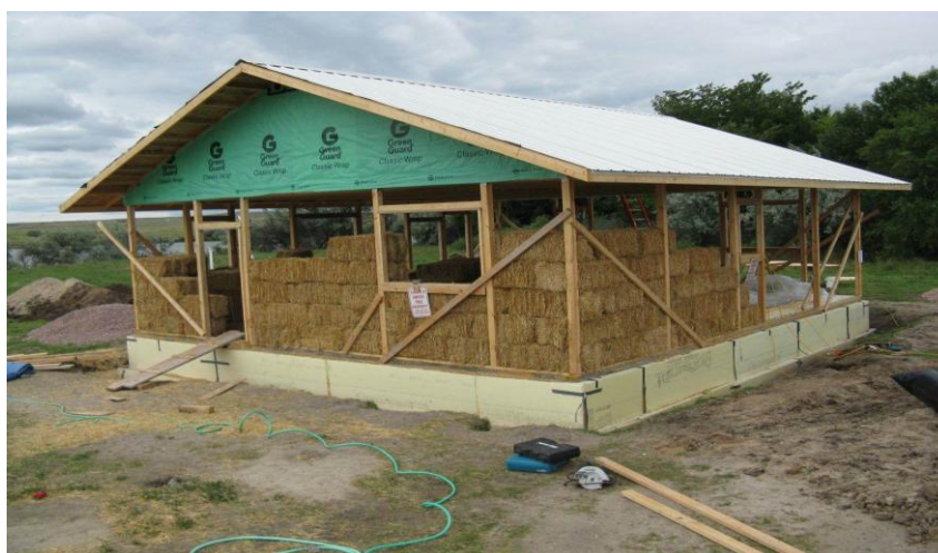
Slika 6. Gradnja kuće metodom laganih konstrukcijskih okvira [8]
