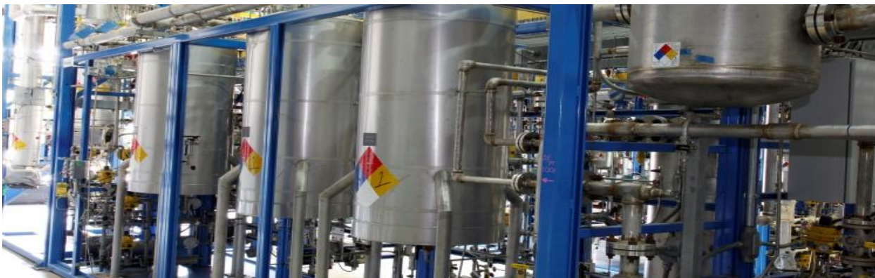
Slika 4. Oprema za proizvodnju adiponitrila u tvornici tvrtke Invista
