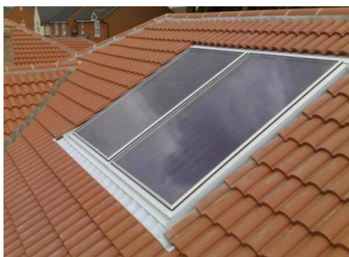
Slika 9. Ugrađeni krovni moduli [11]
