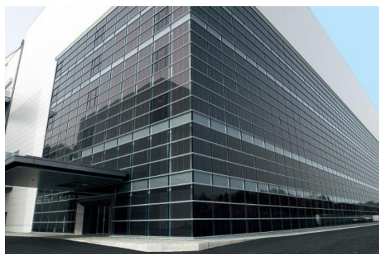
Slika 10. Fasadni solarni generator [12]
