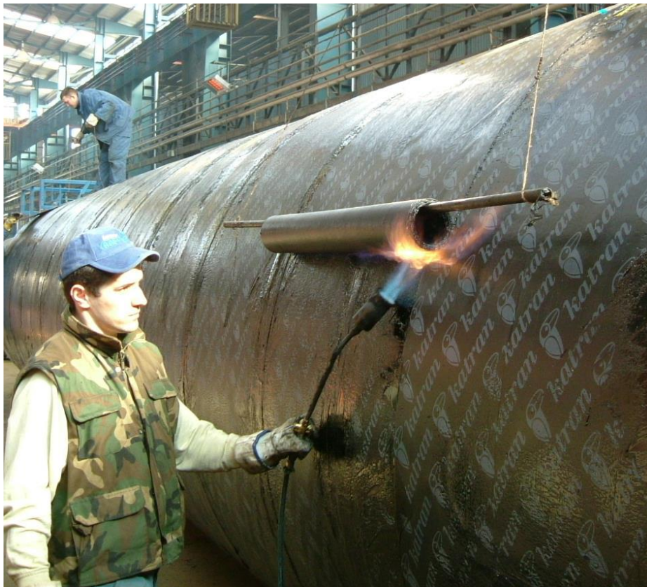
Slika 10: Prikaz izvođenja zaštite bitumenizacijom – čelični spremnik koji će biti ukopan u tlo.
