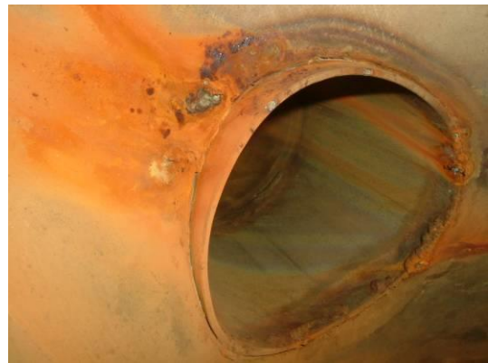
Slika 35: Korozijska oštećenja nastala u području cijevnog ogranka koji strši, AISI 304L, voda, nekoliko mjeseci.
