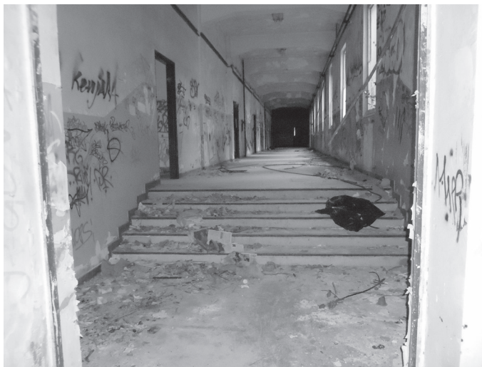
Centar za mlade i proširenje Gradske knjižnice čekaju europski novac, a zgrada propada – unutrašnjost zgrade nekadašnjih spavaonica AŠC-a
