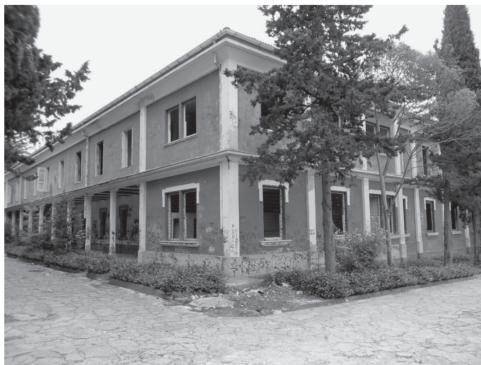
2003. započinje proces traženja stavljanja u funkciju zgrade bivših spavaonica AŠC-a
