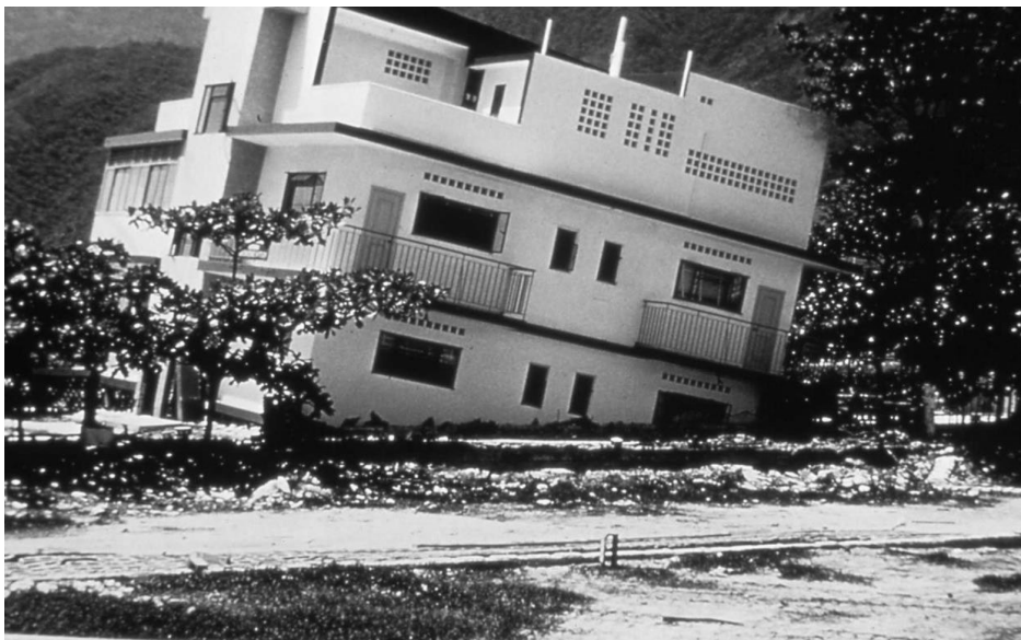
Sl. 2. Uranjanje inače vrlo čvrste kuće u potpuno saturirano pjeskovito tlo koje je zbog prirasta pornih pritisaka likvefiralo, tj. izgubilo krutost i čvrstoću [2]
