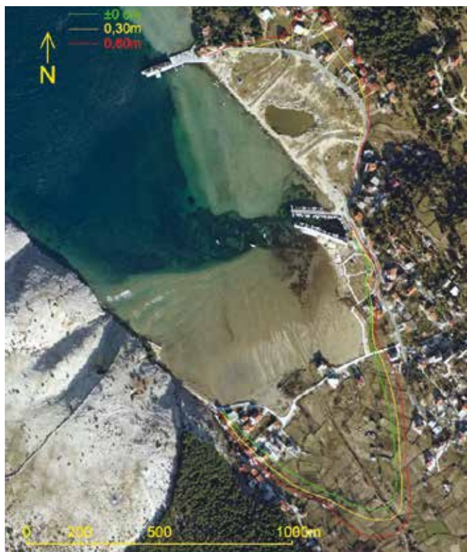
Slika 12. Uvala Lopar: učinak plavljenja u slučaju visoke morske razine 100 godišnjeg povratnog perioda (1,30 m n.m.) i predviđenih stagnacija i povećanja razina mora od 30 i 60
