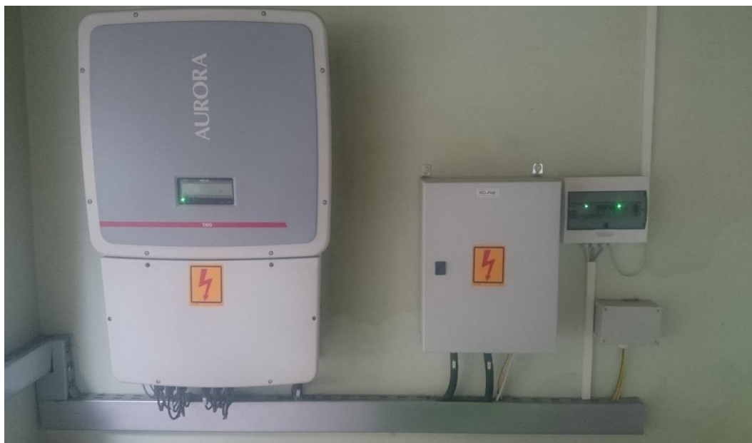
Slika 4. Izmjenjivač Aurora Power-One TRIO-27.6 spojen na FN sustav i mrežu
