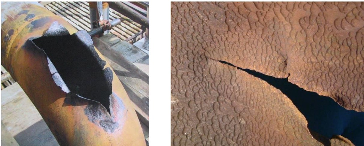
Slika 28: Posljedica erozijsko korozijskog oštećenja cjevovoda za transport nafte [3]
