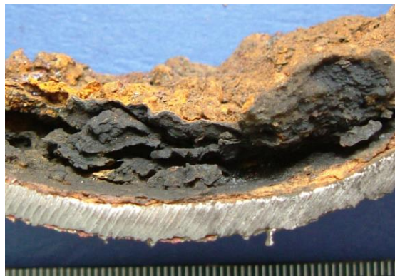
Slika 12: Korozijski produkti nad unutrašnjom stjenkom oštećene čelične cijevi – vidljiv je njihov voluminozan karakter.
