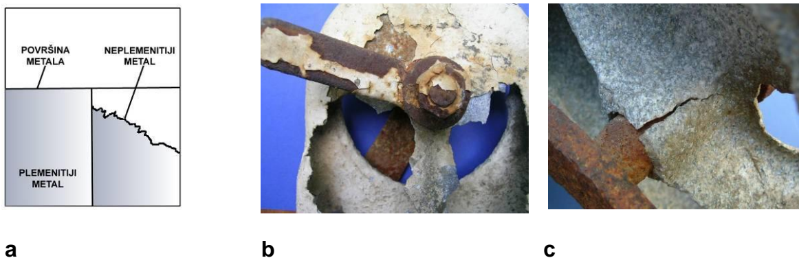
Slika 15: Galvanska korozija: a – shematski prikaz, b- stezni zatvarač čije je kućište napravljeno od aluminijske legure u kontaktu s ugljičnim čelikom od kojeg je izrađen stezni element na konstrukciji broda. Aluminijska legura je neplemenitija od ugljičnog čelika, od kojeg je izrađen stezni element, što ima za posljedicu nastanak galvanskog članka i intenzivnog korozijskog razaranja, a nastali korozijski produkti, čiji je volumen značajno veći od volumena uništenog metala, uzrokuju naprezanja koja mogu rezultirati lomom (slika c).
