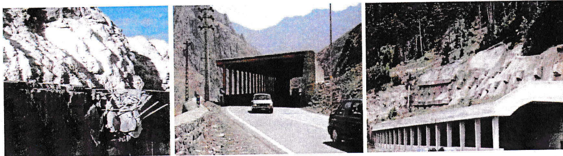
Slike 9 – 11. Armiranobetonski zid (9 - lijevo) i armiranobetonske galerije (10 – sredina, 11 - desno). Zid zbog neelastičnosti očito nije izdržao udar kamena.
