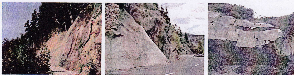
Slike 4 – 6. Primjeri zaštite pokosa mlaznim betonom. Na slikama se dovoljno jasno zapažaju loše strane primijenjene zaštite.
