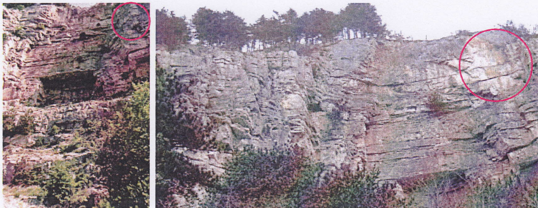
Slike 28 – 29. Na slici 28 (snimljeno 1995. g.) vidi se detalj čela «Raspadalice» sa zaokruženim mjestom (isto mjesto zaokruženo je na slici 29, snimljenoj 2007. g.) s kojega se odronilo oko 500 m 3 stijenske mase u 1999. g. U zoni prikaza sa slike 28 alpinisti su pred više godina (prije 1995.) postavili eksploziv i minirali dio nestabilnih blokova.
