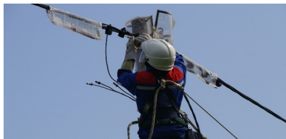
Slika 4. Spajanje SKS priključka na SKS mrežu
