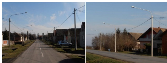
Slika 2. Primjer izolirane niskonaponske mreže na armiranim betonskim stupovima [3]
