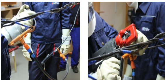
Slika 5. Primjer popravljivanja jednog vodiča SKS- kabela
