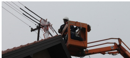
Slika 3. Operater u RPN izolira vodljive dijelove neizolirane gole mreže
