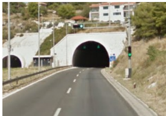
Slika 1. Efekt crne rupe (tunel Mravince)
