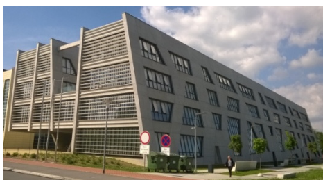
Slika 4. Zgrada Građevinskog fakulteta u sveučilišnom kampusu u Osijeku
