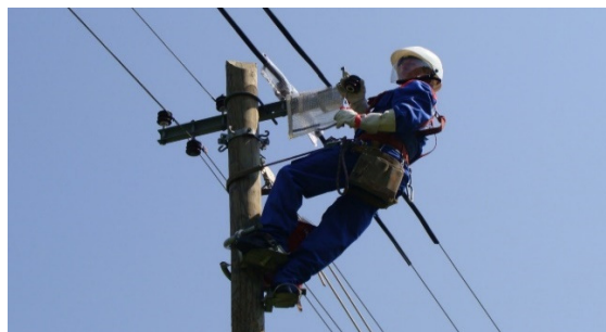
Slika 6. Operater na drvenom stupu vrši izmjenu izolatora u RPN
