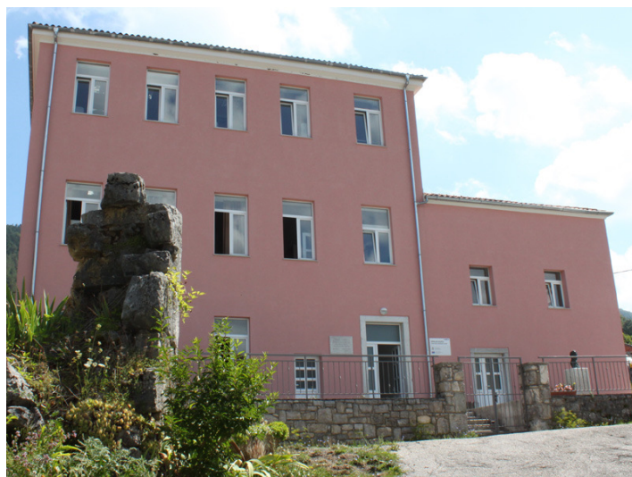
Slika 37. Pregled na u okviru projekta dovršen i opremljen objekt ZEC-a Speleo kuća u Vodicama
